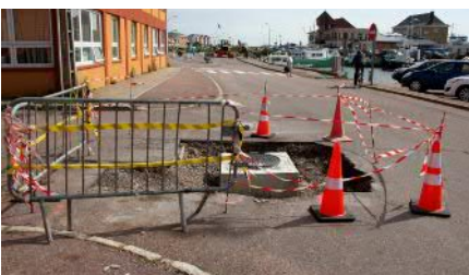
Avant le remplacement du revêtement, les regards et bordures sont remis à niveau. Pour assurer une bonne stabilité, le béton doit durcir complètement avant l'application de l'enrobé. Photo - DTAM.
