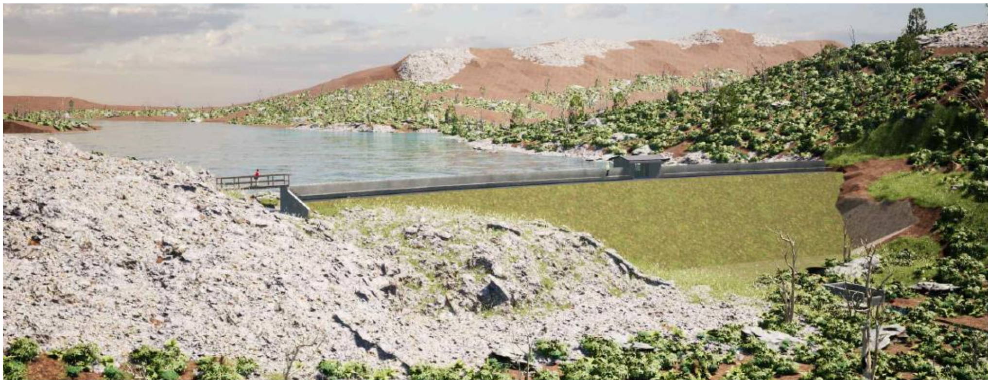
Figure 6: Vue du parement aval
