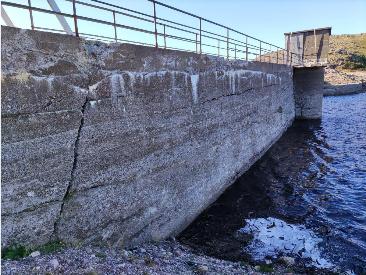
Figure 2: Vue du parement amont du barrage
