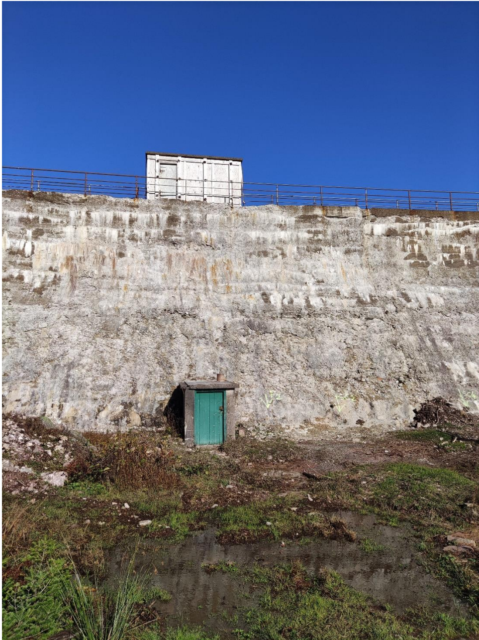
Figure 1:Vue du parement aval
